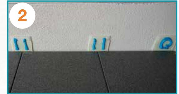
Bringen Sie nun Kleber auch auf der zweiten Seite des FlieSo-Flex an. Der Kleber darf nicht in die Gleitschienen gelangen.
