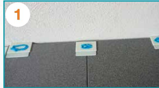
Kleben Sie den FlieSo-Flex mit der schmaleren Seite auf Höhe der Oberkante der Bodenfliese mit geeignetem Kartuschenkleber fest. Eine Platte muss immer mittig der Fuge platziert werden, damit beim späteren Verfugen keine Verbindung zur Wand entsteht.
